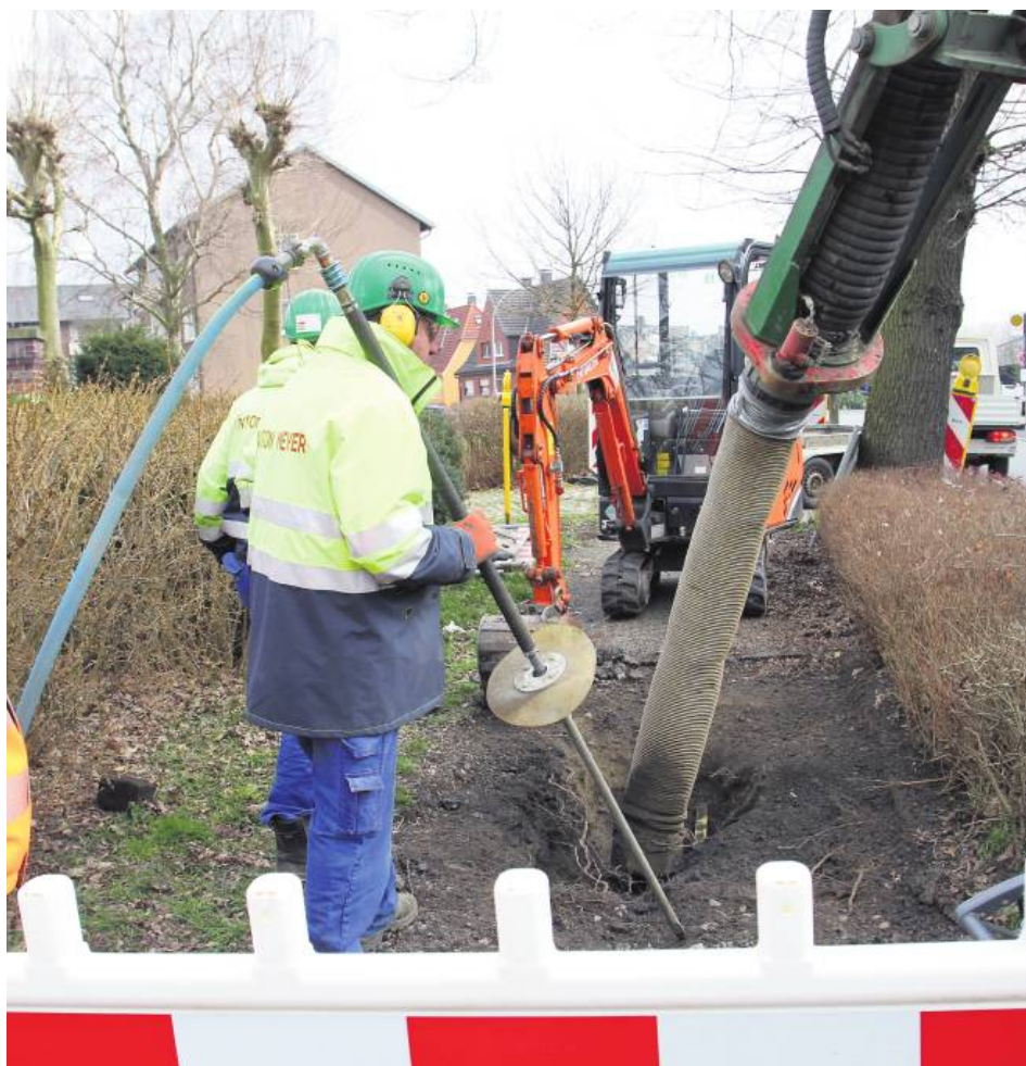
An drei Stellen in Werne lässt Thyssen Gas derzeit die Erdgasleitungen untersuchen – ob sie von den Wurzeln der Kastanien und Eichen Schaden genommen haben: an der Lippestraße in Höhe der Firma Böcker (Foto r.u.) sowie in der Nähe des Spielplatzes am Fischerhof (L.) und an der Capeller Straße.
